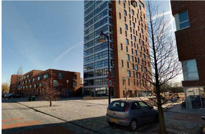
Bebouwing Granaatplein en Diamantlaan
