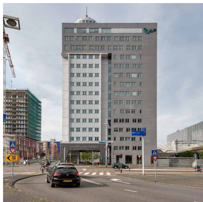
Leiden SVB-toren, bovenbouw
