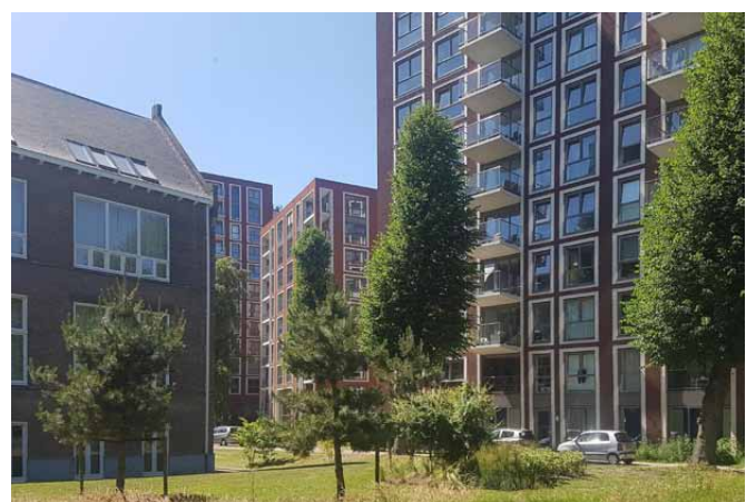
Schilperoortpark Leiden, toren in het groen
