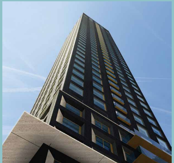
Baan Tower, Rotterdam Voorbeeld slanke toren
