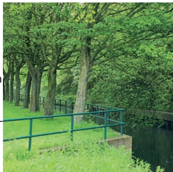
Damwand met hek bij Azurietskade
